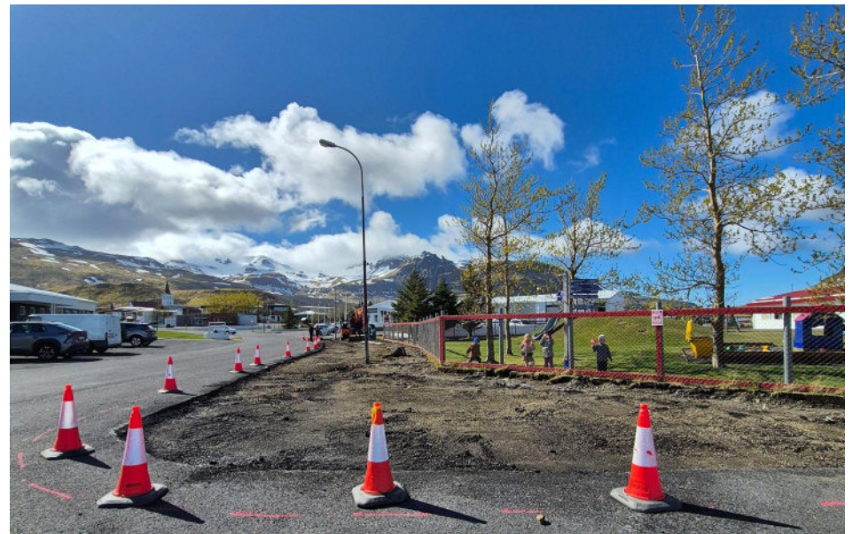
Framkvæmdir við gerð blágrænna ofanvatnsrása meðfram Hrannarstíg.
