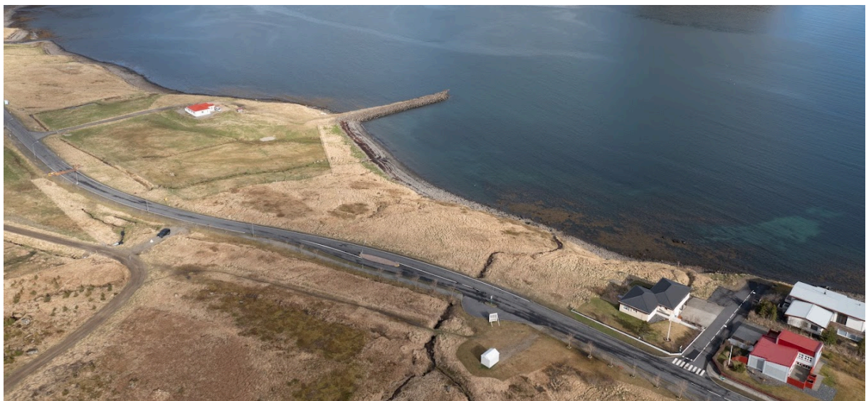
Horft yfir Háubakka.
