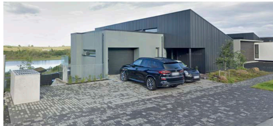
Mynd 4.3 Fyrirmyndir sem sýna grasstein og aðrar tegundir af gegndræpum hellum, bílastæði og sorpskýli á lóð.
