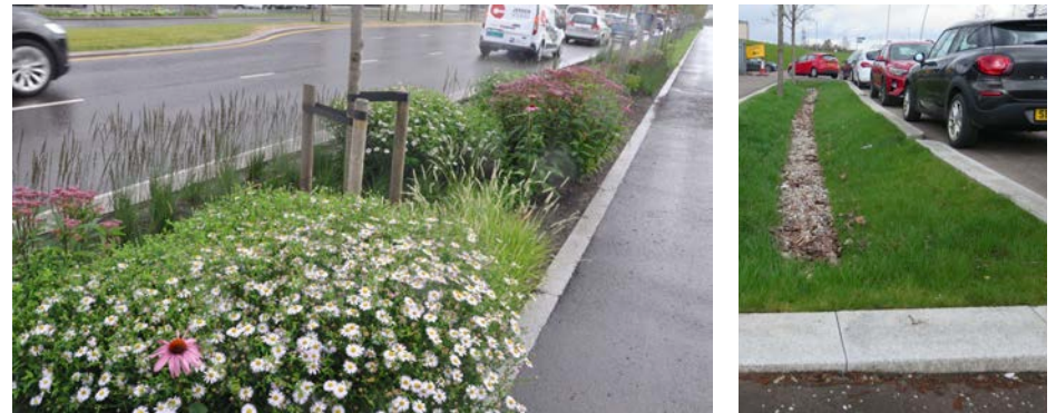
Fordæmismyndir frá Urriðaholti í Garðabæ (efst) og erlendis (neðri), sem sýna ofanvatnsrásir meðfram götum.
