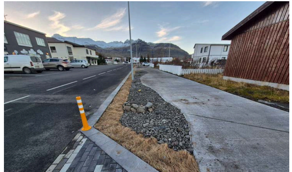
Viðhalda þarf ofanvatnsrásum sumar sem vetur til að tryggja vatnsflæði.
