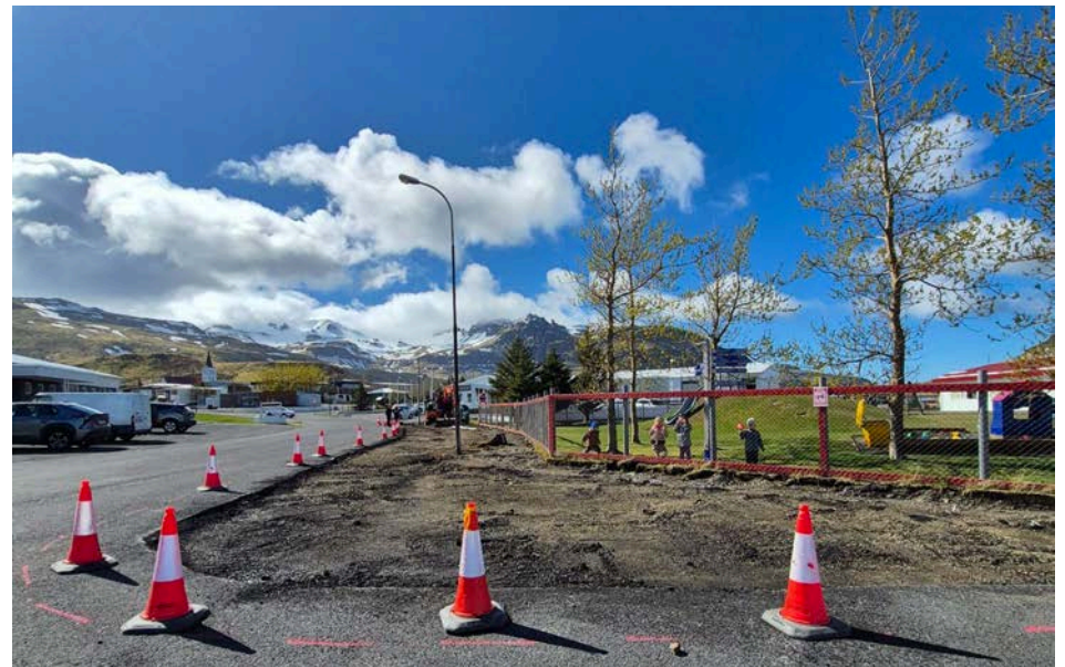
Framkvæmdir við blágrænar ofanvatnsrásir meðfram Hrannarstíg.
