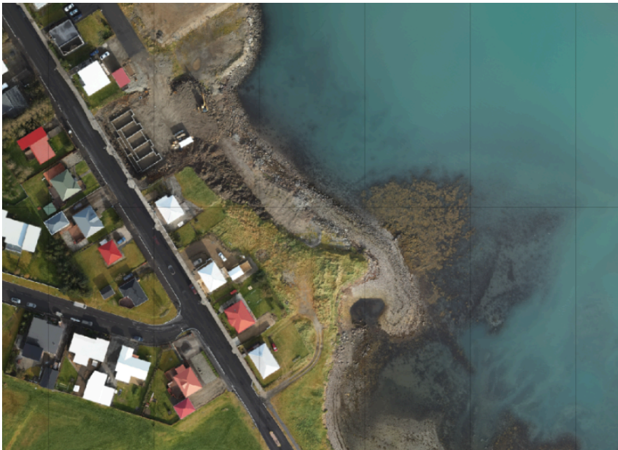
Mynd 4.2 Loftmynd af hluta framkvæmdasvæðis landfyllingar.
