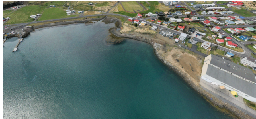
2.1: Mynd tekin í suðvestur yfir hluta framkvæmdasvæðisins í átt að Gilósi.
